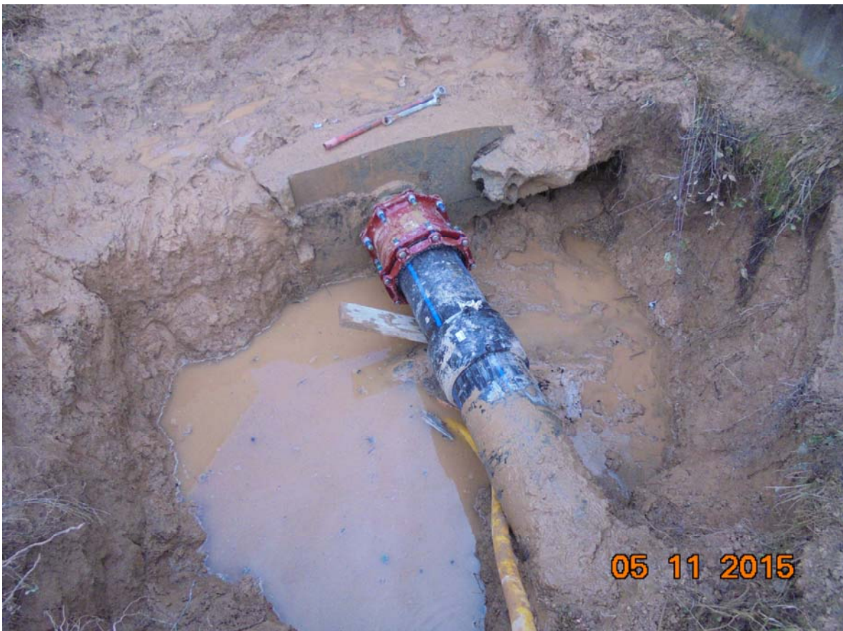
Reparació del rebentament a la línia del Cardener a Llera (5-11-2015)
