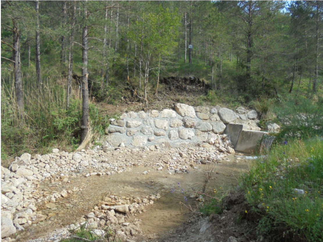
Reparació escullera i accés Riulacó. Tram parada aigua (6-6-2016)
