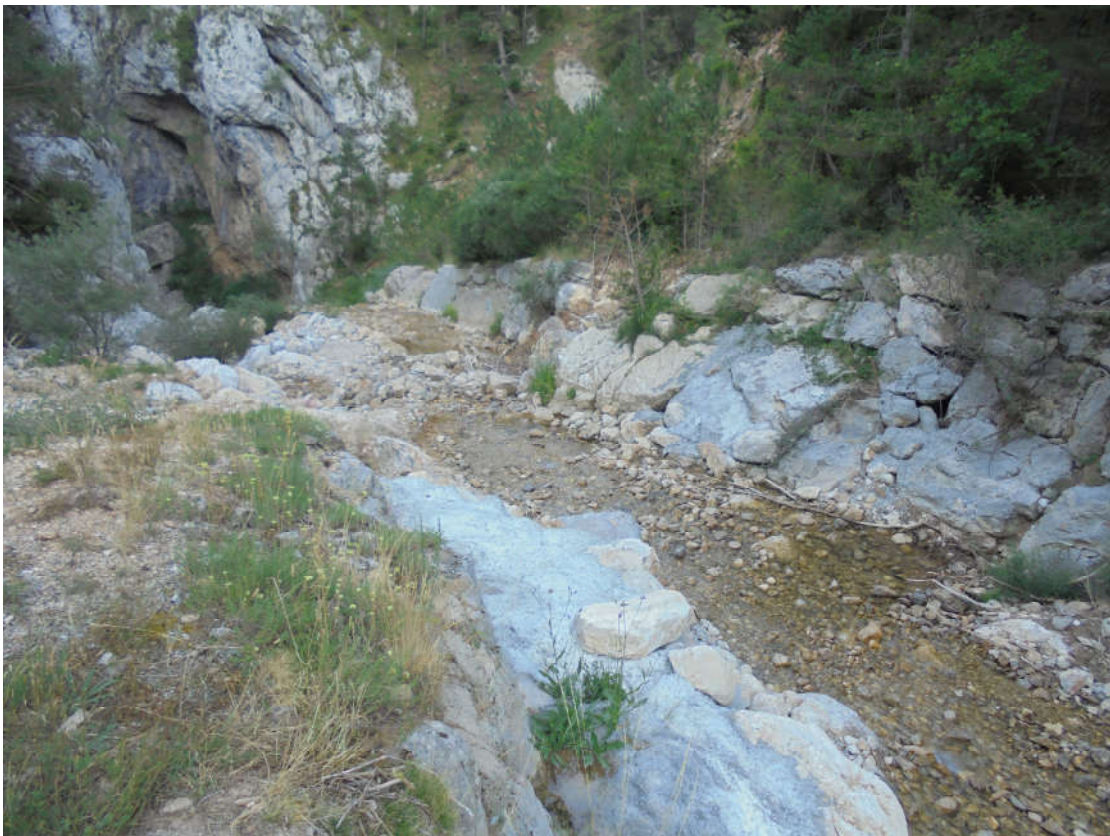
Reparació escullera i accés Riulacó. Tram inferior (3-8-2016))
