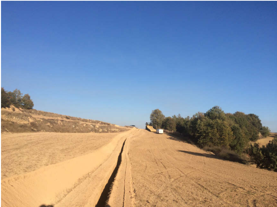
Línia Hostal Nou a Biosca. Començament de la rasa (2-11-2016)
