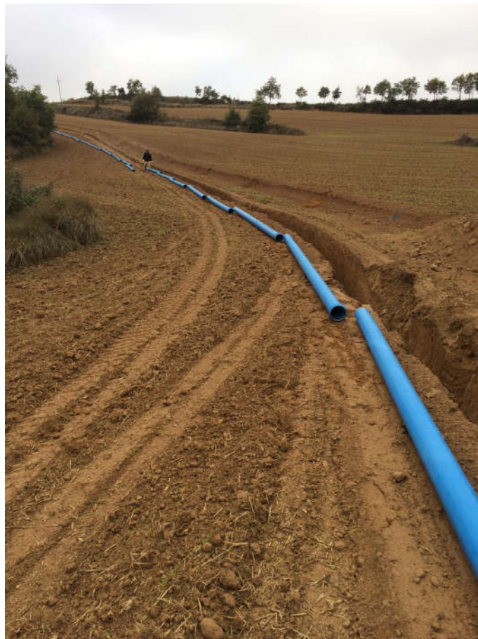
Línia Hostal Nou a Biosca. Estesa canonada PVC-O DN 160 (7-11-2016)
