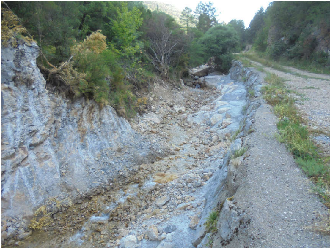
Reparació escullera i accés Riulacó. Tram superior (3-8-2016)
