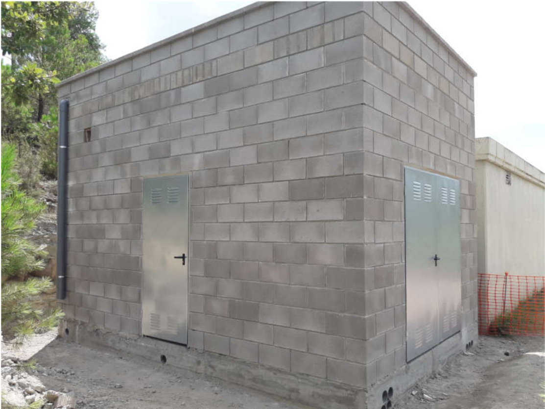
Nova caseta de cloració a Cabot (10/12/2018)
