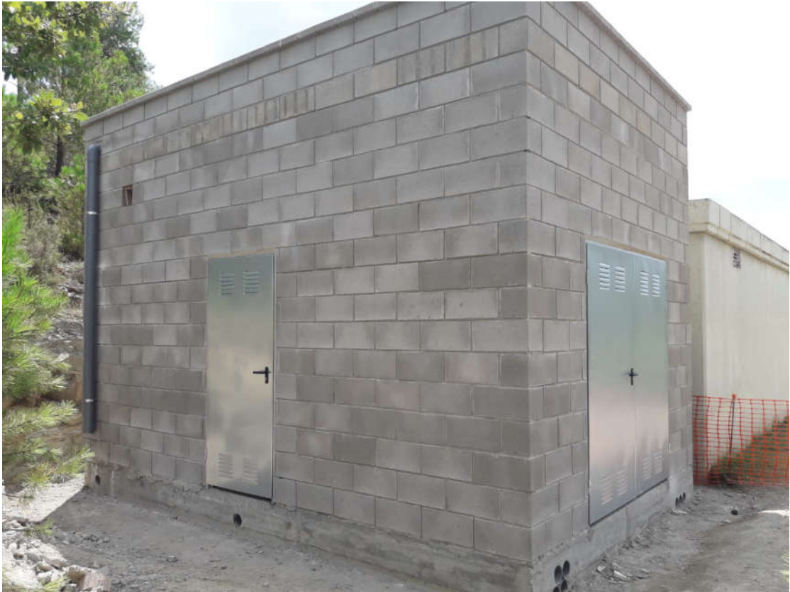
Caseta de cloració a Cabot, Pinós (10/2/2019)
