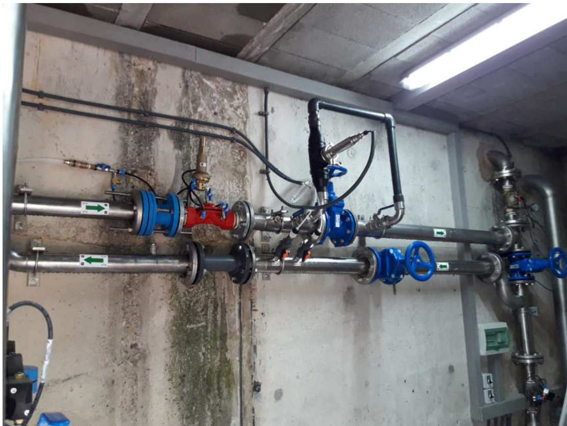
Canonades i turbidímetre a l'ETAP de Timoneda (20-08-2019)
