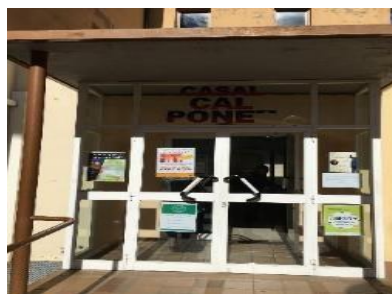
Figura 2. Entrada de Cal Ponet. Font pròpia.
