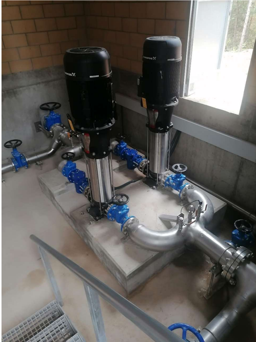
Llera a Torregassa, interior bombat (21-10-21)
