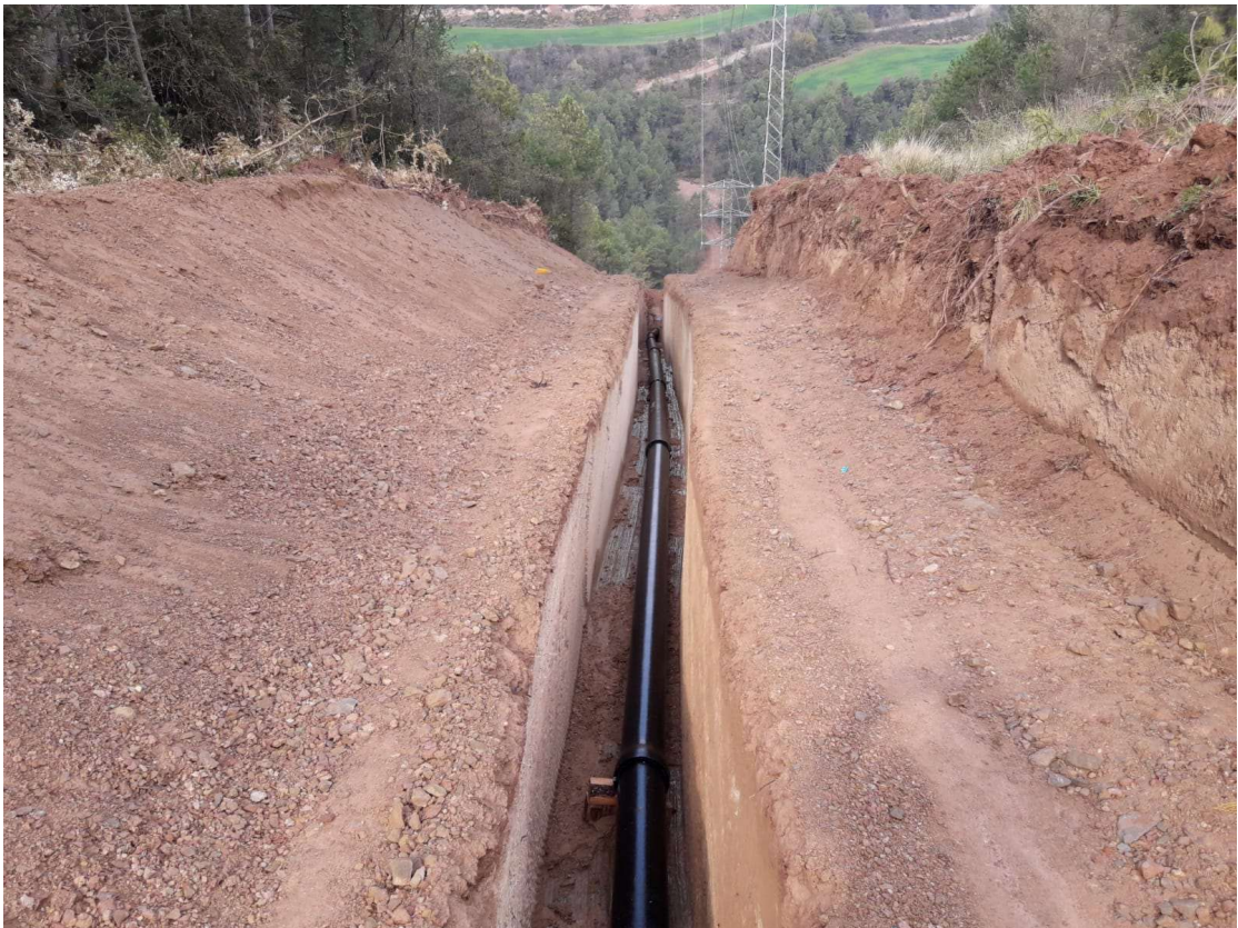
Llera a Torregassa, rasa amb tub fosa DN 200 (16-04-2021)
