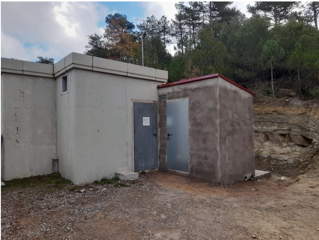
Nova caseta al dipòsit Cabot (01-12-2022)
