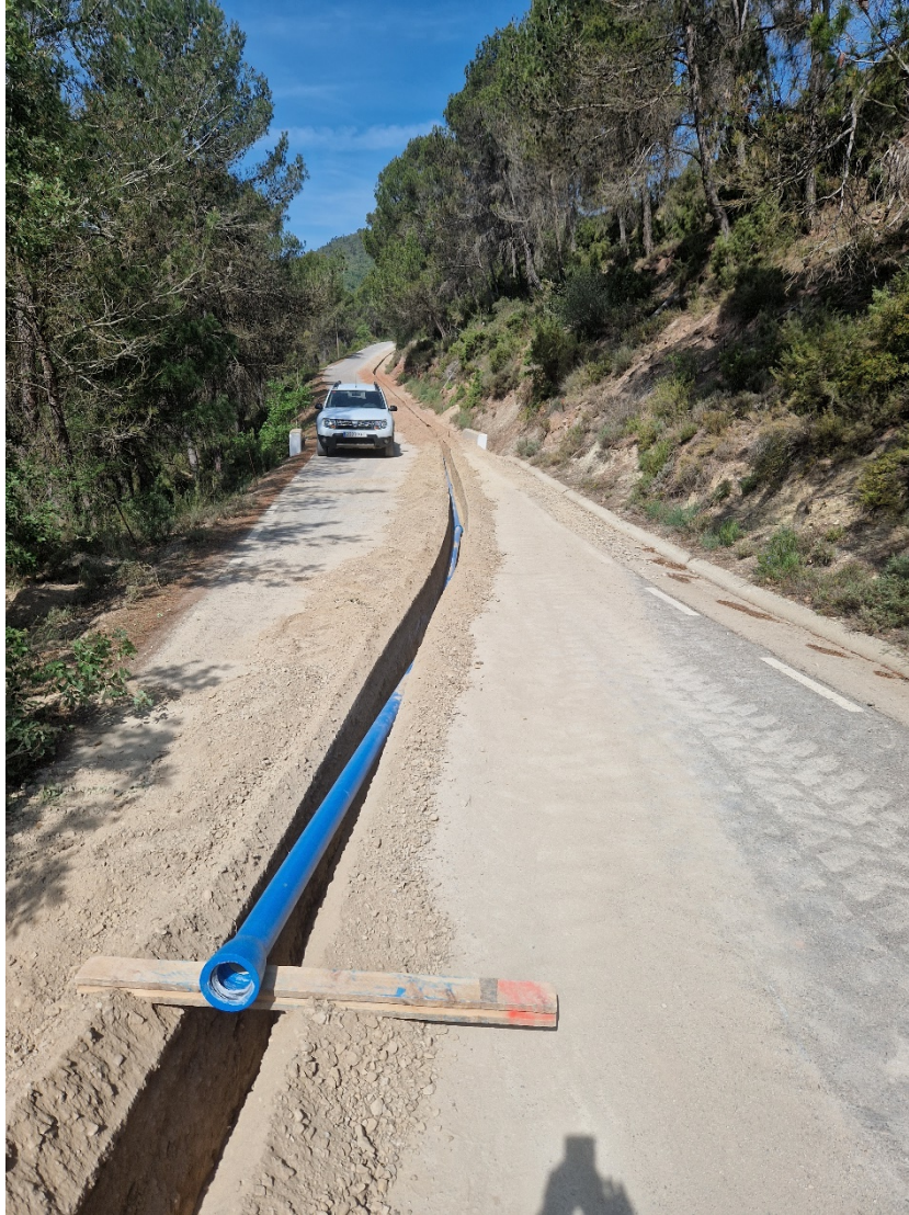
Tub fosa DN 80 de Cabot a Santuari (18-05-2022)
