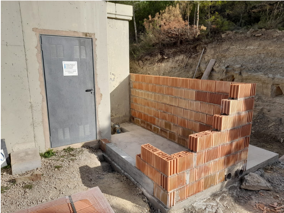
Fonamentació i parets caseta Cabot (02-11-2022)
